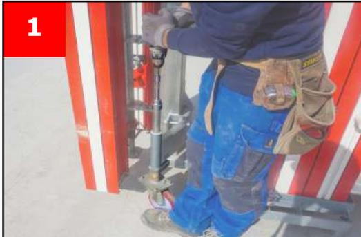
Die klappMAX Schalbox per Kran, Stapler, Hubwagen oder integriertem Rollensystem an Ort und Stelle platzieren.
