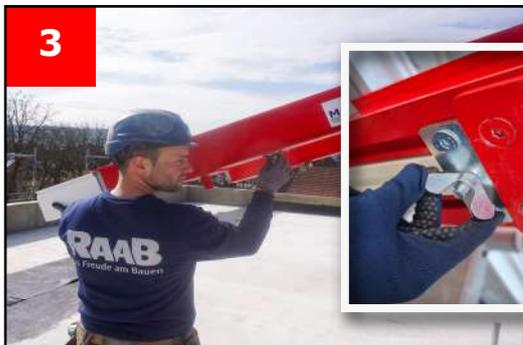
Sicherung der Einschubträger lösen, Träger auf Maß ausziehen und mit der integrierten Flügelschraube wieder sichern.
