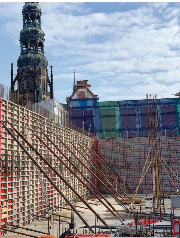
Nicht alltäglicher Sichtbetoneinsatz SB2 für die Mayer-Ultramax auf der Campus-Baustelle in Zwickau mit Wandhöhen bis 5,8 m. Wegen der regelmäßigen Rahmenabdrücke und des symmetrischen Ankerbilds haben die Architekten die 3,0 x 1,5 m großen Ultramax-Elemente zur Sichtbetonschalung „befördert“.
