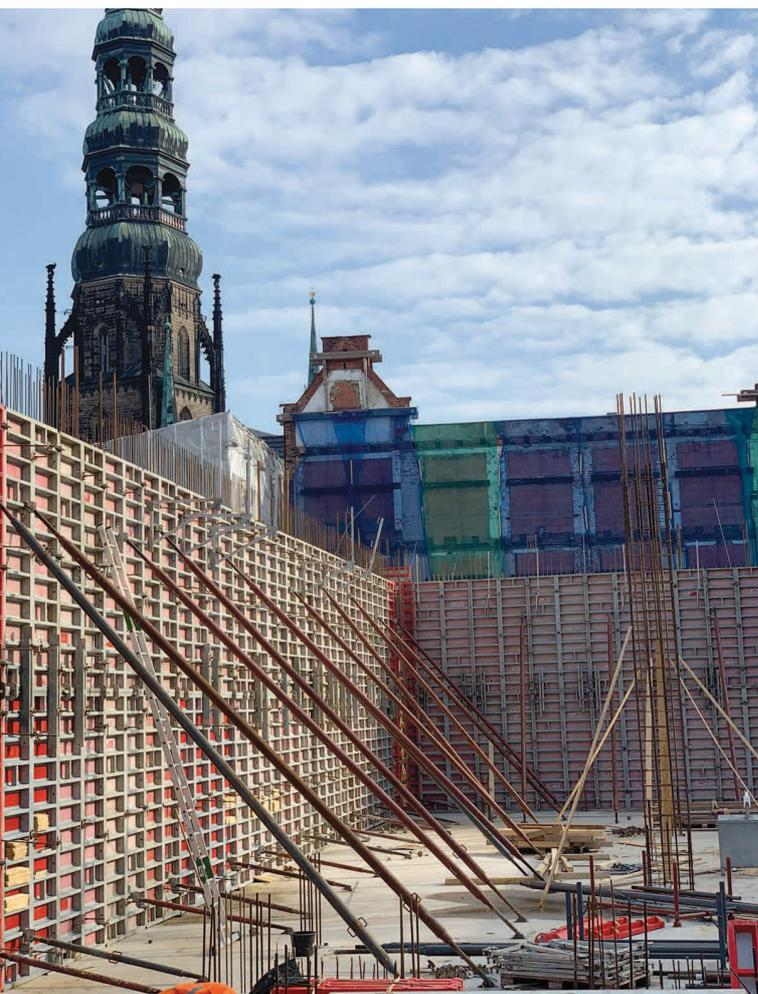
**Nicht alltäglicher Sichtbetoneinsatz SB2 für die Mayer-Ultramax auf der Campus-Baustelle in Zwickau mit Wandhöhen bis 5,8 m. Wegen der regelmäßigen Rahmenabdrücke und des symmetrischen Ankerbilds haben die Architekten die 3,0 x 1,5 m großen Ultramax-Elemente zur Sichtbetonschalung „befördert“.**
