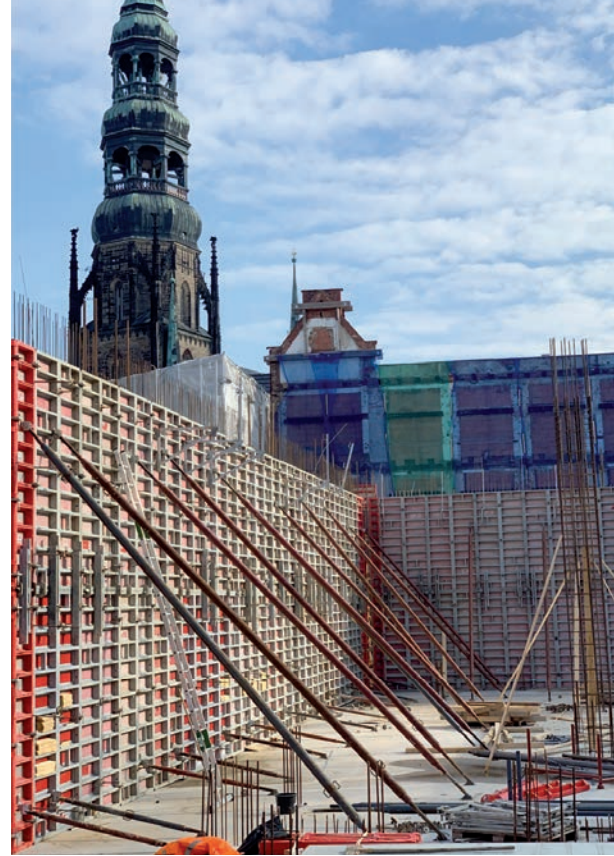
Auf dem Zwickauer Campus: Wegen der regelmäßigen Rahmenabdrücke und dem Ankerbild haben die Architekten auf der Baustelle die Ultramax-Elemente zur Sichtbetonschalung „befördert“. Foto: Mayer Schaltechnik
