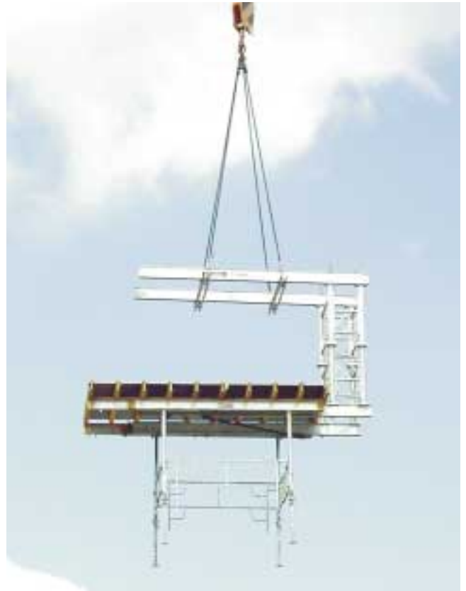
Deckentisch mit stellMAX , Kranversatz
