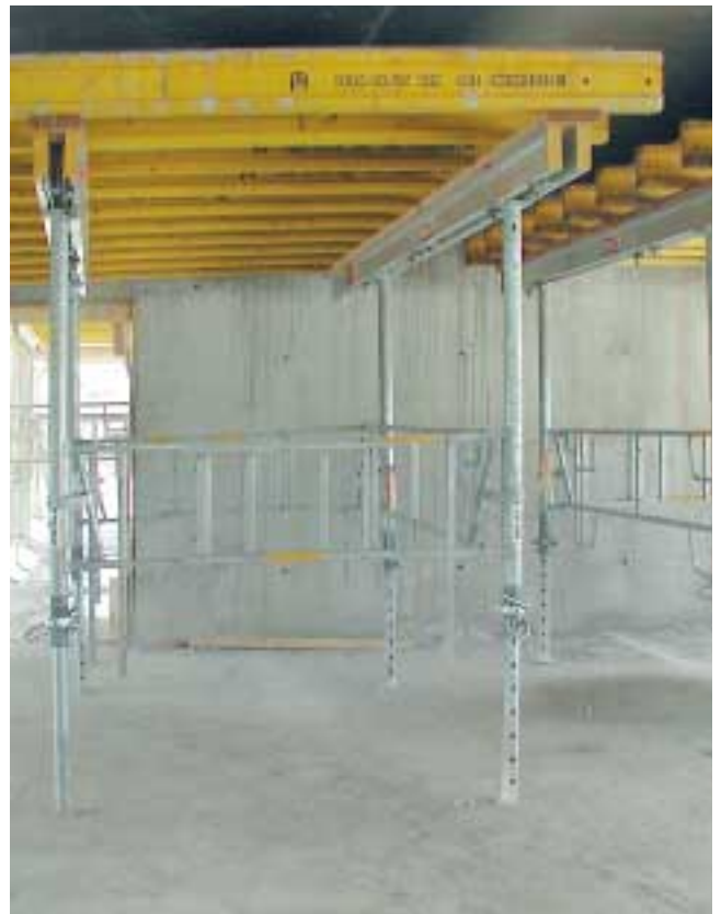
Deckentisch mit miniMAX -Joch, Verwaltungsgebäude, Ottobrunn
