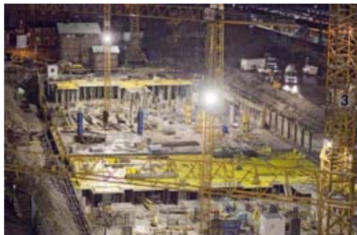
Die Alu-Träger liegen in einer Ebene und können sich jedem Grundriss anpassen. Der Fallkopf ermöglicht das frühe Ausschalen und die Schalung kann erneut eingesetzt werden Bilder: Mayer
