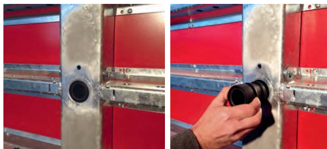
Abb. 5a–c: Ankerung einhäutig geschalter Wand mit Einsteckmutter und von außen eingeführtem Abstandhalter – mit Hebelwerkzeug wird die Ankerstange eingedreht
