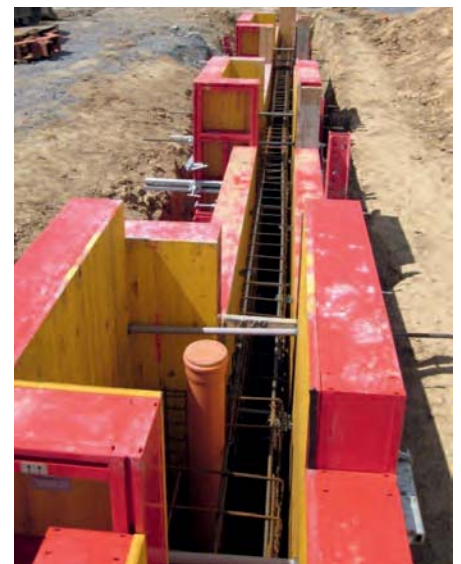
Abb. 1: aluMAX Aluminiumschalung ohne gesonderte Eckelemente
