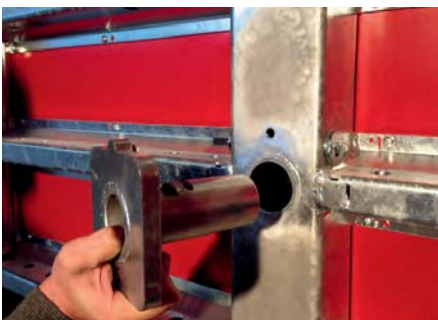
Abb. 5a–c: Ankerung einhäutig geschalter Wand mit Einsteckmutter und von außen eingeführtem Abstandhalter – mit Hebelwerkzeug wird die Ankerstange eingedreht
