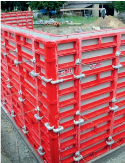
Abb. 2: ultraMAX L Rahmenschalung mit nur einem Verbindungsteil und simpler 90°-Ecklösung
