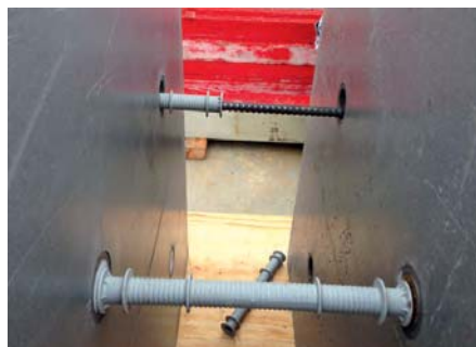
Abb. 5a–c: Ankerung einhäutig geschalter Wand mit Einsteckmutter und von außen eingeführtem Abstandhalter – mit Hebelwerkzeug wird die Ankerstange eingedreht
