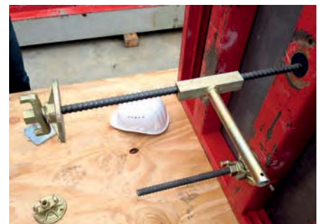
Abb. 5a–c: Ankerung einhäutig geschalter Wand mit Einsteckmutter und von außen eingeführtem Abstandhalter – mit Hebelwerkzeug wird die Ankerstange eingedreht
