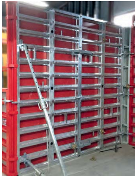
Abb. 3: Die ultraMAX S Rahmenschalung im kleinflächigen Einsatz kranunabhängig
